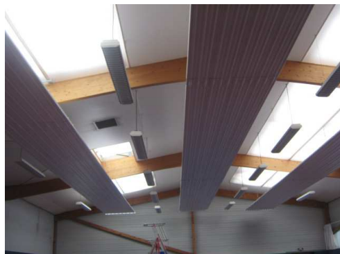
Mise en place de panneaux rayonnants
